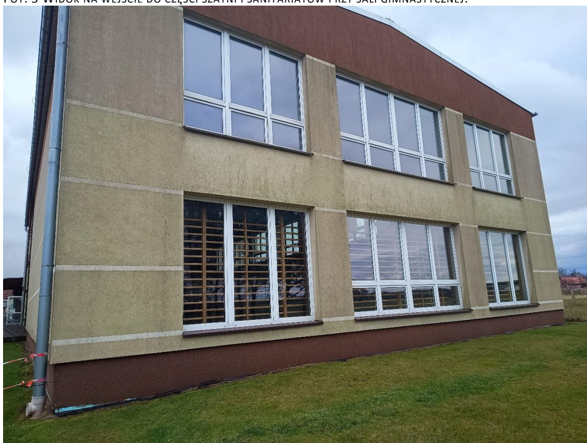
FOT. 6 WIDOK NA SALĘ GIMNASTYCZNĄ. WIDOCZNY BRAK OPASKI WOKÓŁ BUDYNKU SALI GIMNASTYCZNEJ.
